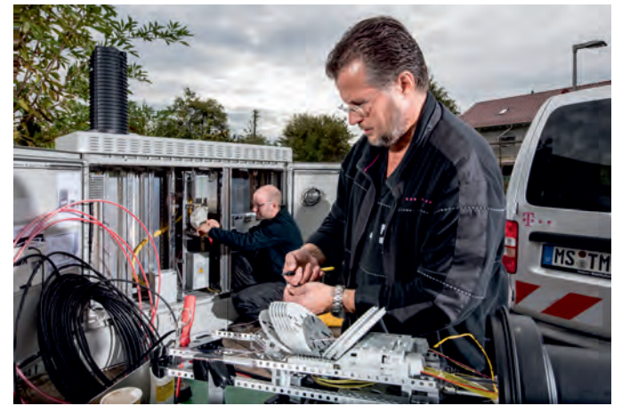
Netzausbau. Glasfaser werden beim Spleißen fachmännisch verbunden
